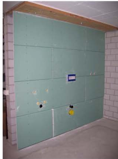
Bild 225: Raumhohe Duofix Vorwandinstallation
